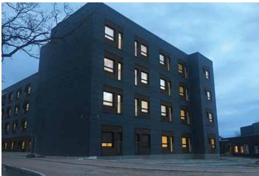
Det nye helsebygget er på nesten 12 000 kvm, men med fasaden i massivtre glir bygget pent inn i omgivelsene.
