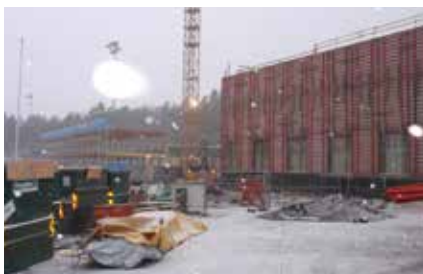
Den høye veggen som ble støpt rett før jul skal forlenges inn mot dekket bak.
