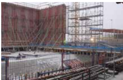
Nå starter stålmontering oppe på dekket inn mot fjellet. Deretter fortsettes det med veggstøp inne i bygget.
